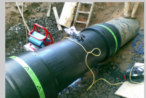
Electrofusion of PE pipes
